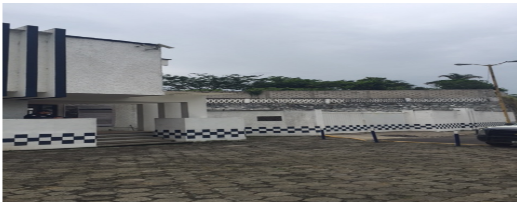
Entrada a las instalaciones de Seguridad Pública
