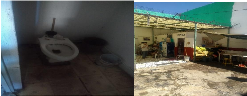
Sanitario y patio CSA4
