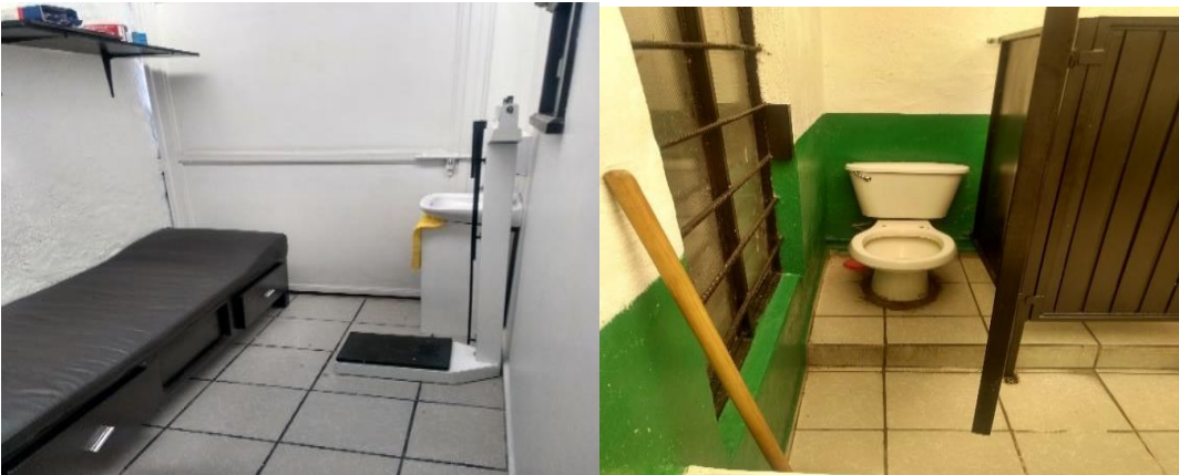
Consultorio y baño en áreas comunes CSA2
