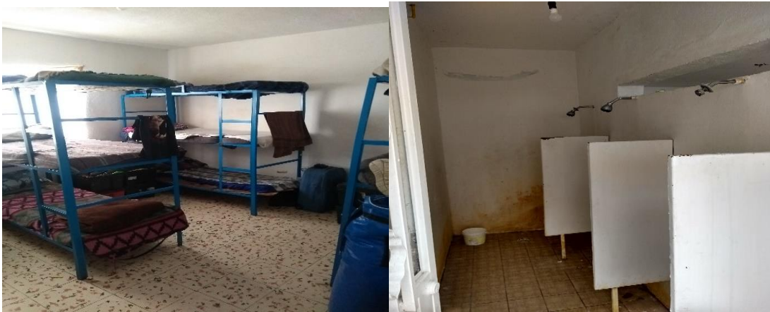
Dormitorio y baños CSA6
