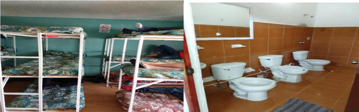
Dormitorio y baños, CST3
