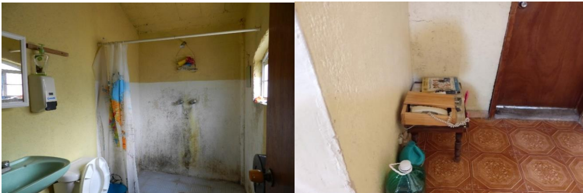
Baño y teléfono, CST5
