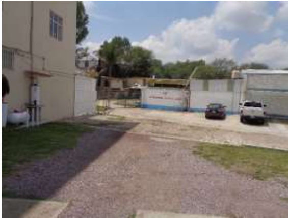
Infraestructura - Representación del Instituto Nacional de Migración en el Estado de Aguascalientes. Visitas realizadas del 07 al 11 de septiembre de 2020.
