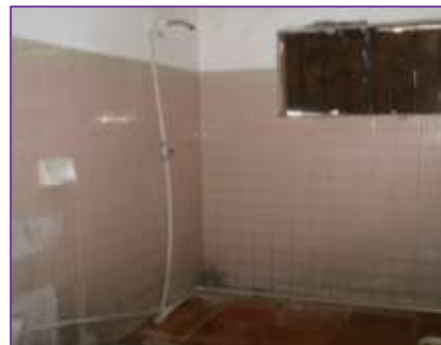
Sanitarios del CSC5
