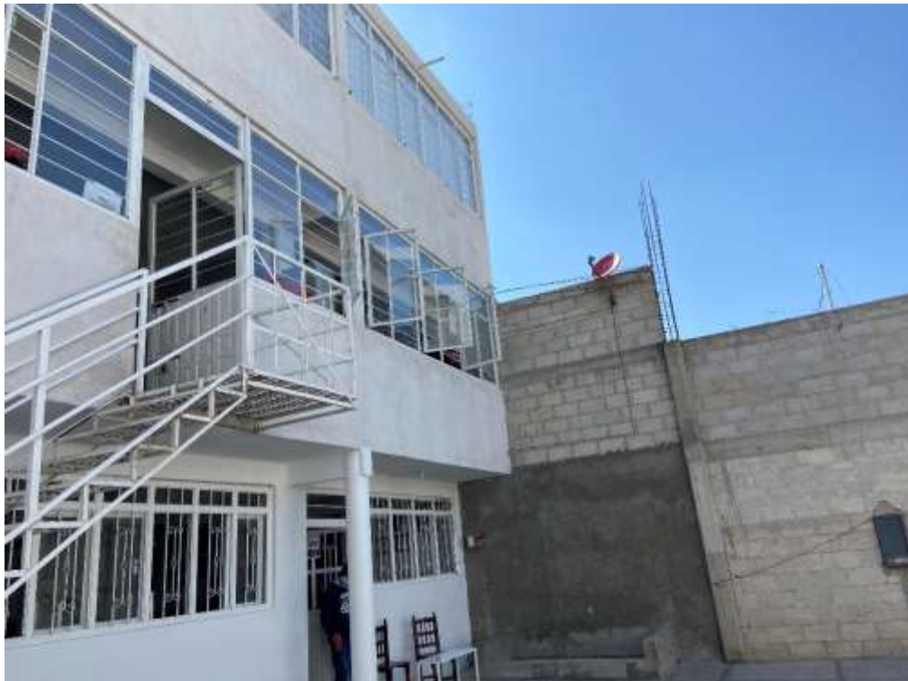
Infraestructura del Albergue del DIF del Estado de Tlaxcala. Visitas realizadas del 05 al 09 de octubre de 2020.
