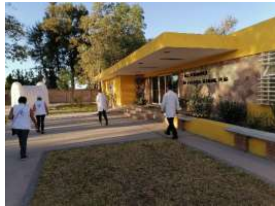
Fachada de la Clínica Psiquiátrica “Everardo Neuman Peña”, en el Estado de San Luis Potosí, capturada durante las visitas de supervisión realizadas, del 26 al 30 de octubre de 2020, por el MNPT.
