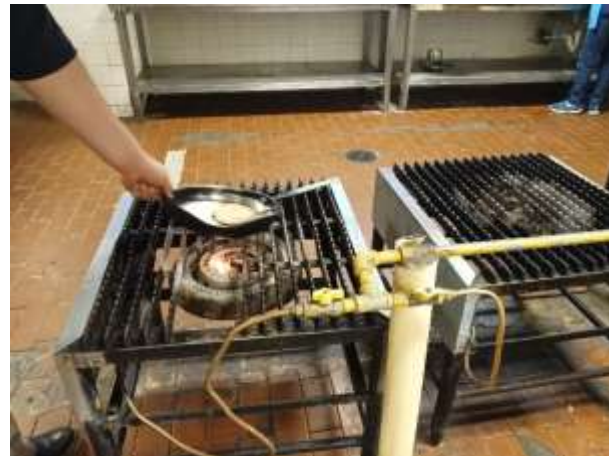
Cocina y alimentos del Hospital Psiquiátrico “Cruz del Norte”, en el Estado de Sonora. Visitas realizadas del 09 al 13 de noviembre de 2020.
