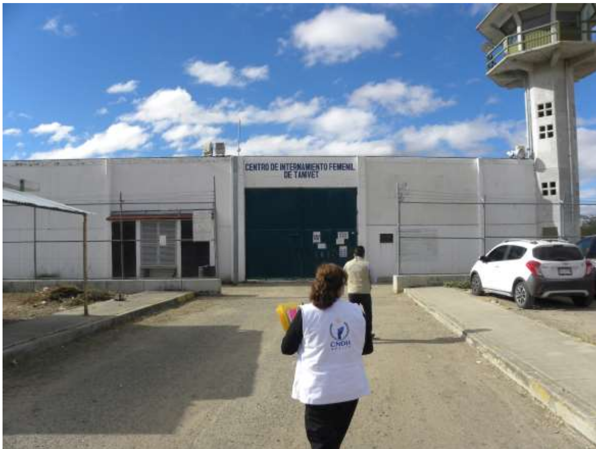
Fachada del Centro Penitenciario Femenil de Tanívet en el Estado de Oaxaca - Visitas realizadas del 17 al 20 de noviembre de 2020.
