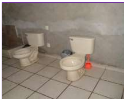
Sanitarios del CSC2
