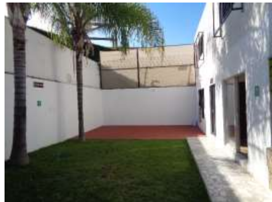
Infraestructura de la Estación Migratoria en Guadalajara – Jalisco, autoridad que brindó respuesta al oficio enviado por el MNTP, con relación a la solicitud de medidas implementadas a causa de la COVID-19.
