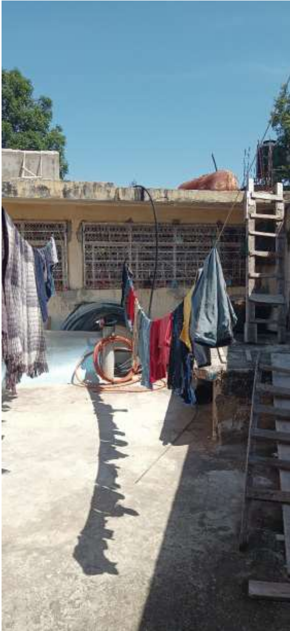
Infraestructura del Centro de Rehabilitación "Raquel Miranda de Díaz", A. C., en el Estado de Guerrero. Visitas realizadas del 05 al 09 octubre de 2020.
