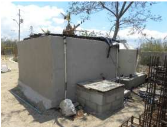
Infraestructura - Albergue para Menores "Nueva Creación", A. C., en el Estado de Baja California Sur. Visitas realizadas del 07 al 11 de septiembre de 2020.
