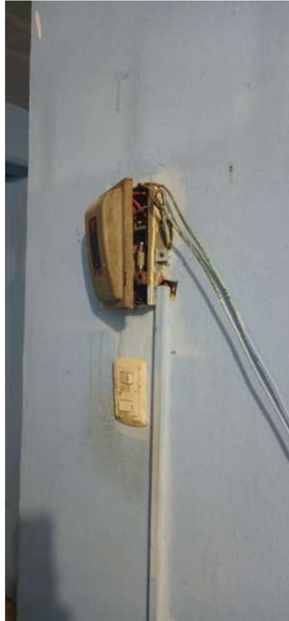
Infraestructura del Centro de Rehabilitación "Raquel Miranda de Díaz", A. C., en el Estado de Guerrero. Visitas realizadas del 05 al 09 octubre de 2020.
