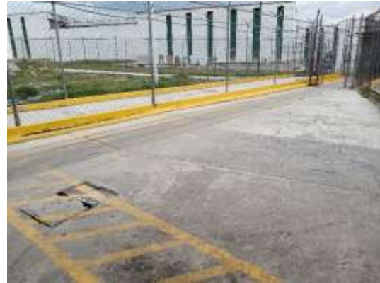
Infraestructura del Centro Penitenciario de Puebla, autoridad que brindó respuesta al oficio enviado por el MNTP, con relación a la solicitud de medidas implementadas a causa de la COVID-19.
