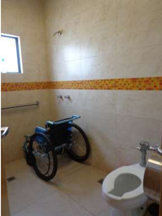
Sanitarios - Albergue Temporal Mexicali en el Estado de Baja California. Visitas realizadas del 07 al 11 de septiembre de 2020.
