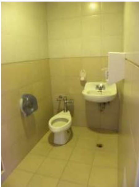
Sanitarios del Hospital Psiquiátrico de Tampico en el Estado de Tamaulipas. Visitas realizadas del 09 al 13 de diciembre de 2020.
