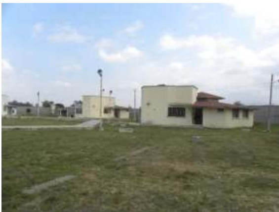
Infraestructura del Centro Regional de Ejecución de Medidas para Adolescentes de Güémez , Tamaulipas - Visitas realizadas del 09 al 13 de noviembre de 2020.
