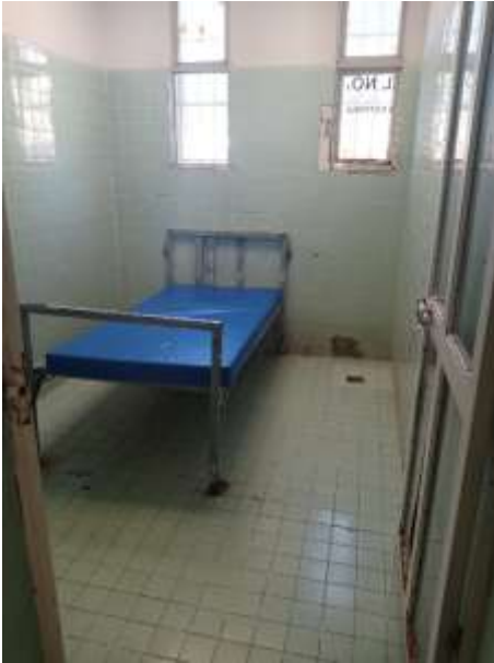
Dormitorio del Hospital Psiquiátrico “Cruz del Norte”, en el Estado de Sonora. Visitas realizadas del 09 al 13 de noviembre de 2020.
