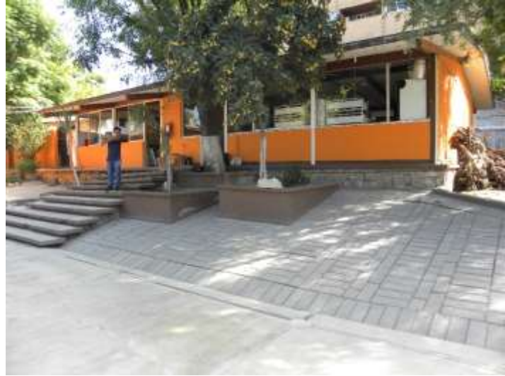
Infraestructura del Centro contra las Adicciones Drogadictos Anónimos, A.C. "Grupo La Búsqueda 1" ubicado en el Estado de Guanajuato, autoridad que brindó respuesta al oficio enviado por el MNTP, con relación a la solicitud de medidas implementadas a causa de la COVID-19.
