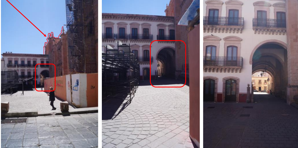
Imágenes de la lateral norte de la catedral, realizando captura de imágenes hasta llegar al acceso frontal del callejón.
